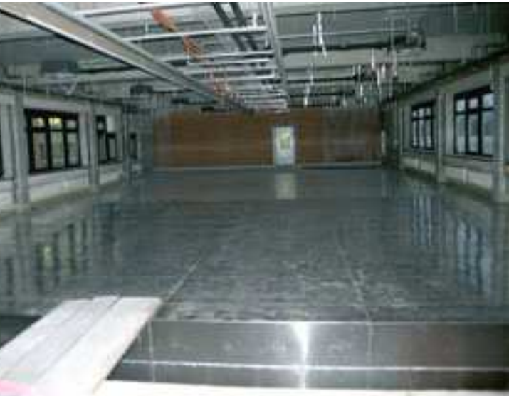
Le blindage des surfaces étendues d'un immeuble de bureaux contre une station de transformation sous-jacente avec les panneaux de blindage Aaronia MagnoShield®
